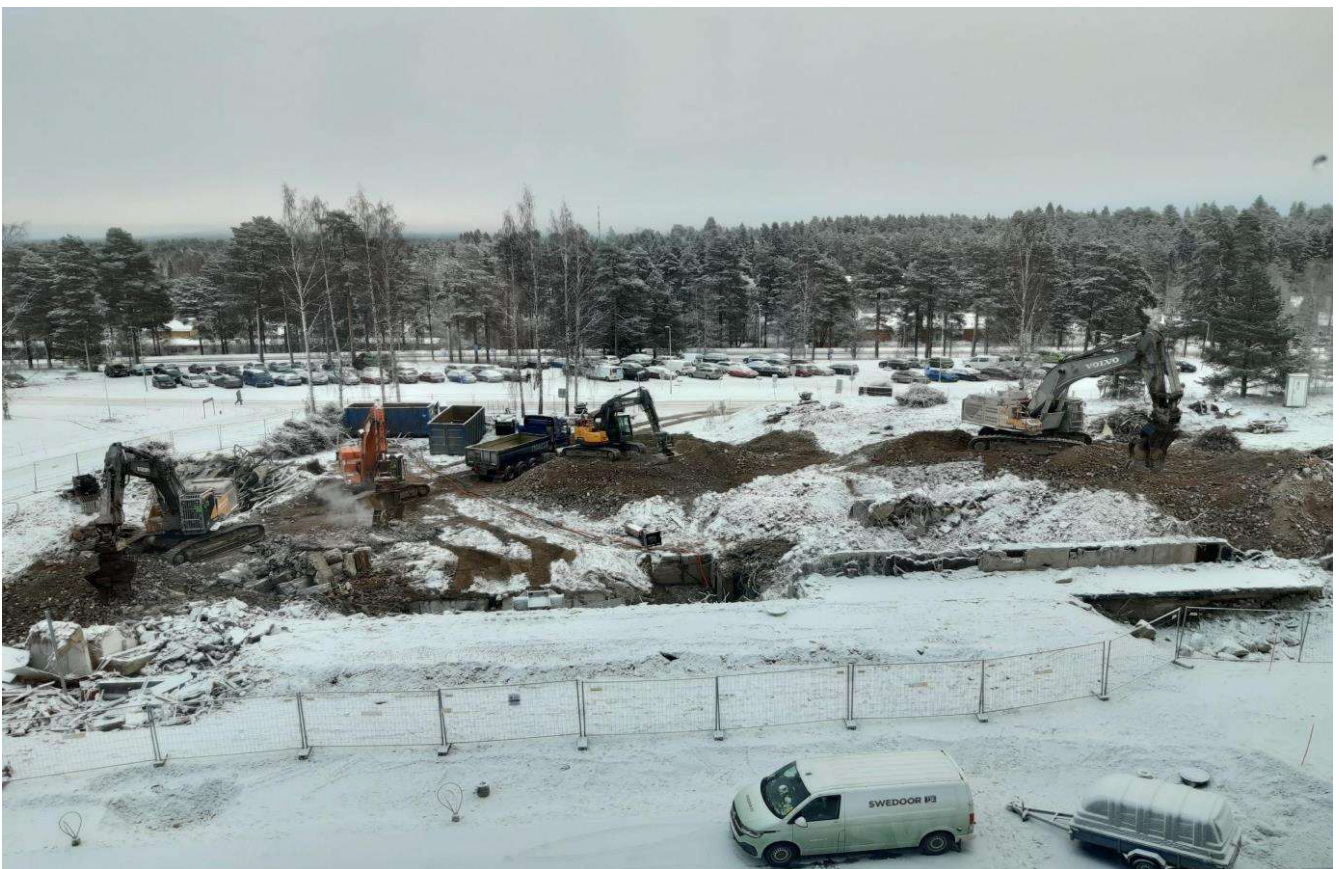
Aika aikaansa kutakin. Kainuun keskussairaalan purkutyömaa 9.11.2022.
